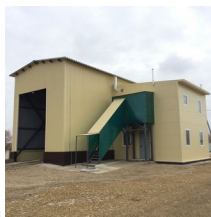
Строительство лаборатории с автовесовой и пробоотборником Клиент: хлебоприемное предприятие «Август-Муслюм»
